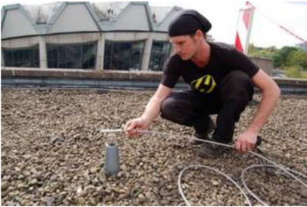
Le câble est passé dans les ancrés
