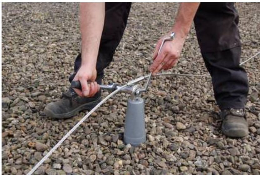
Les ancrés sont serrés sur les potelets Diasafe
