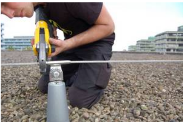
Le câble est mis sous tension à la main entre deux ancrés successives et le sertissage est effectué.
