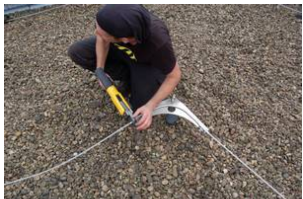
Le câble est mis sous tension à la main entre deux ancrés successives et le sertissage est effectué.
