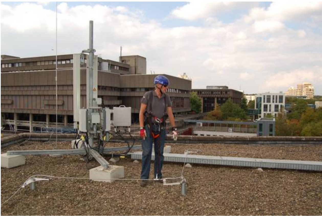
Fig. 1. Ligne de vie Securope sur potelet Diasafe
