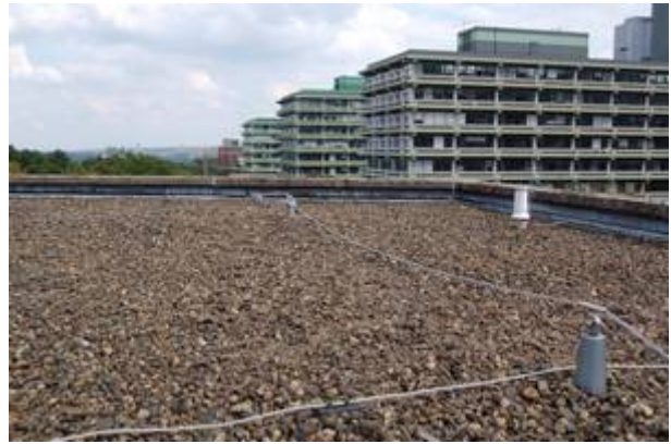
Le câble est passé dans les ancrés
