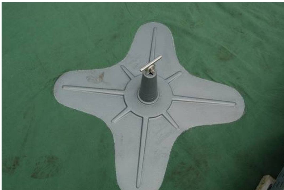
Fig. 3. Potelet Diasafe et le tapis géotextile
