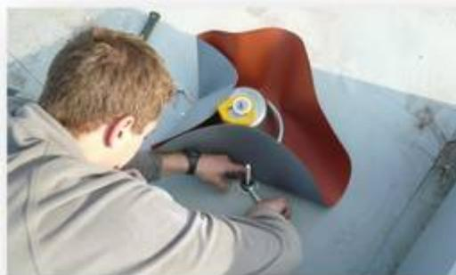
Serrage des boulons et coupe de la sur longueur des tiges filetées.
