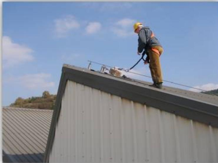
Fig. 11. Ligne de vie Securope sur panneaux sandwich
