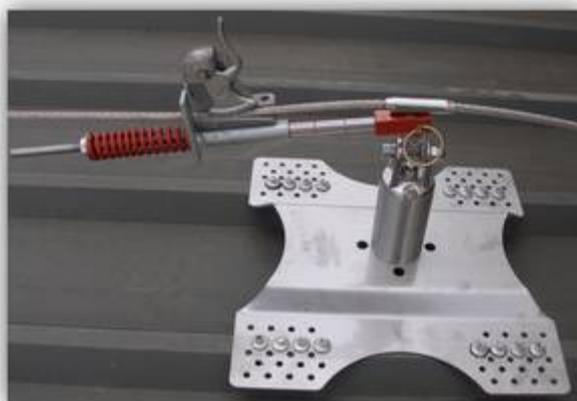
Fig. 14. Mise en tension de la ligne de vie.
