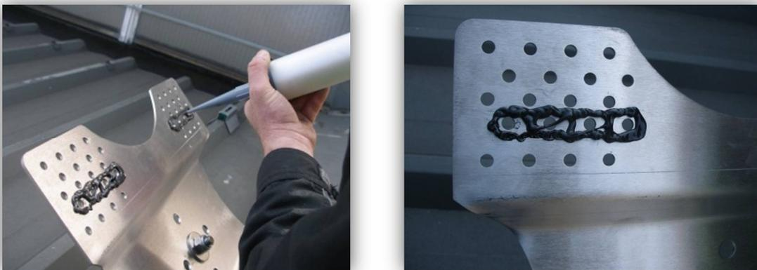
Fig. 12. Application du produit d'étanchéité sur le support d'ancrage.
